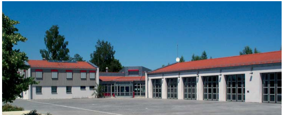
Feuerwehrgerätehaus im Gewerbepark
