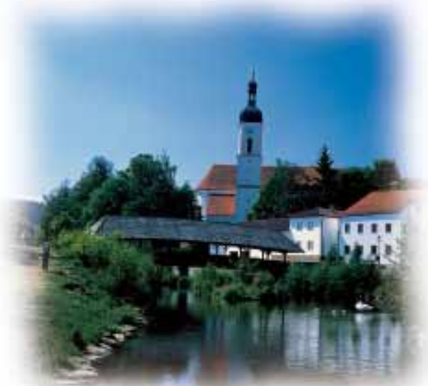
Holzbrücke am Regen
