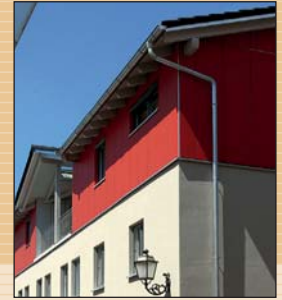
Sanierung und Wohnhausaufstockung - Waldkirchen
