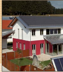
Sichtdachstuhl - Sonnenhaus Kozeny, Waldkirchen
