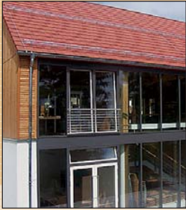
Holz- und Dachkonstruktion - Kulturforum Waldkirchen
