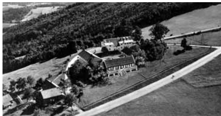
Areal des ehem. Sanatoriums Rusel
