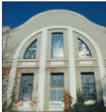
Imposante Jugendstilfassade eines ehemaligen Industriebetriebes
