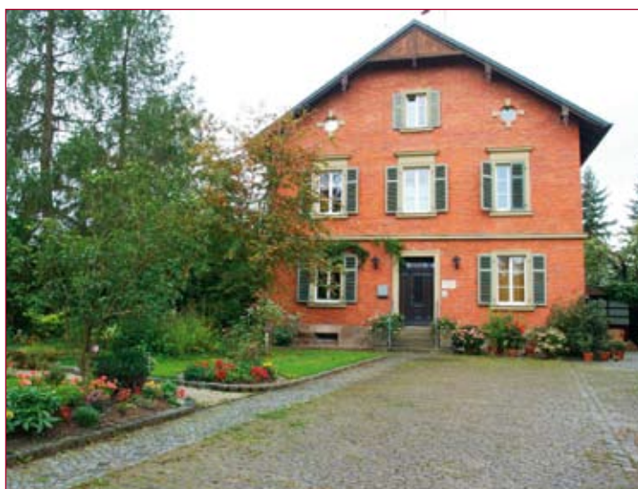
Auch Gebäude aus Klinker sind im Landkreis Bamberg zu finden – hier ein vorbildlich saniertes Gebäude
