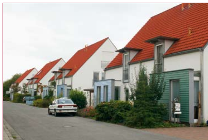
Beispiel für eine gestalterisch gute Lösung der Gebäude und Vorzonen in einem Neubaubereich in der Hans-Glück-Straße in Memmelsdorf
