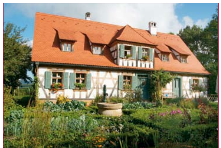
Dieses Beispiel in Demmelsdorf zeigt die Dominanz der Großform gegenüber den untergeordneten Gauben.
