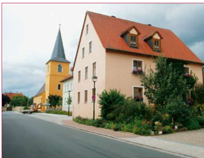
Sanierung in der Ortsmitte in Sambach
