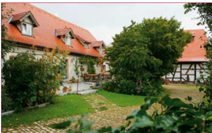
Schlossbauernhof in Stolzenroth, Sanierung
