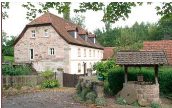
Sanierung einer alten Mühle in Kleinbirkbach, Markt Ebrach
