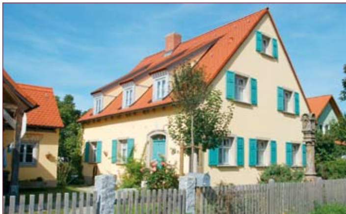
Vorbildlich sanierter Hof in Dörfleins mit behutsam eingefügten Gauben, auch der Zaun ist ein schönes Beispiel für den ländlichen Raum
