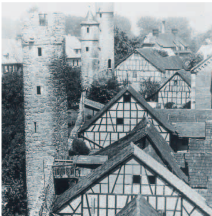
Die Wehrtürme an der Südwestseite der Stadtmauer
