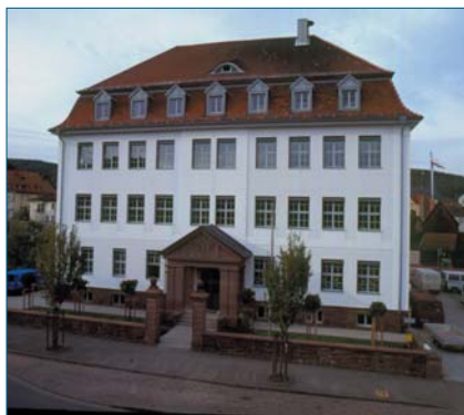
Die Grundschule Lohr wurde vor einigen Jahren von Grund auf saniert.
