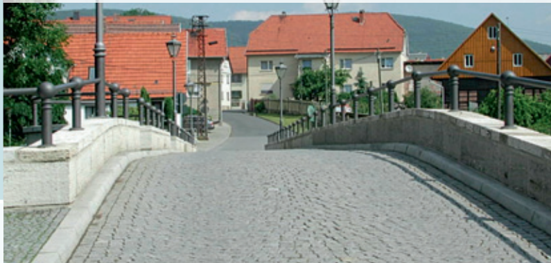
Blick über Werrabrücke, Einhausen
