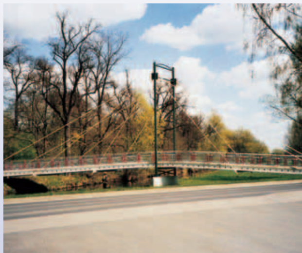
Werra-Brücke zum Schlosspark (Golden Gate Bridge)
