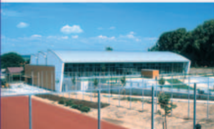
Neubau Dreifelder-Sporthalle mit Mehrzwecknutzung Bliescheroide, 2001-2003
