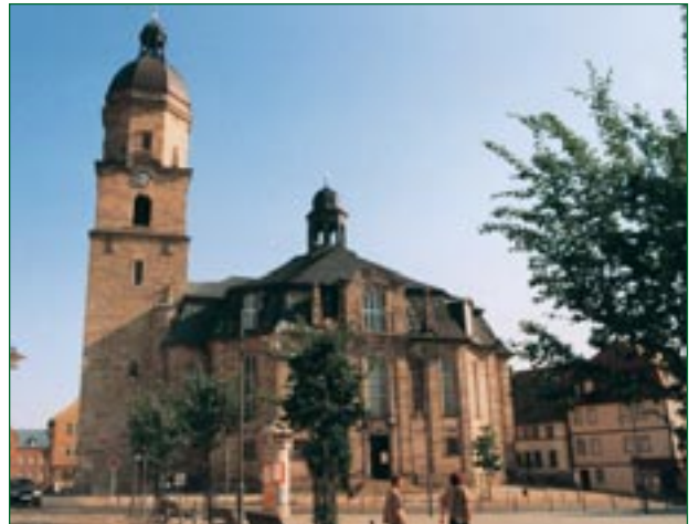
Kirche „Zur Gotteshilfe“ Waltershausen
