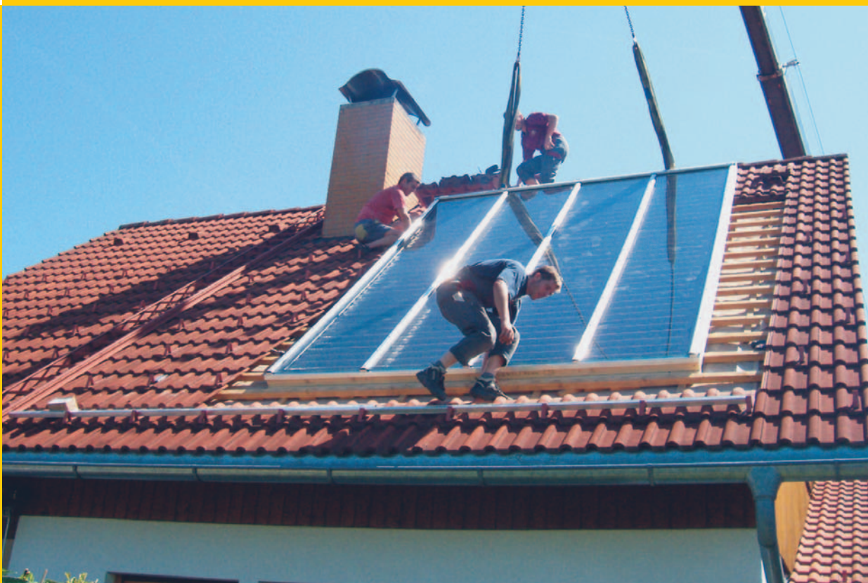
Montage eines Großflächenkollektors
