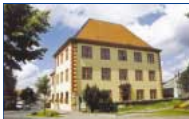
Amtsgerichtsgebäude im Ortsteil Großenlüder.
