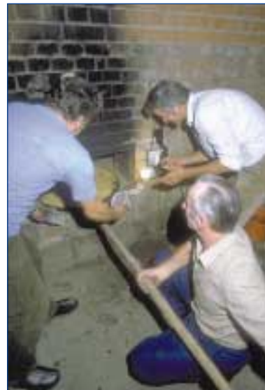
Restauriertes Backhaus in Lütterz.
