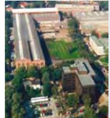
Das BORSIG Werk in Berlin-Tegel, Sitz des Unternehmens seit 1898. Heute werden hier Abhitzesysteme, Spaltgaskühler und Kratzkühler gefertigt.
