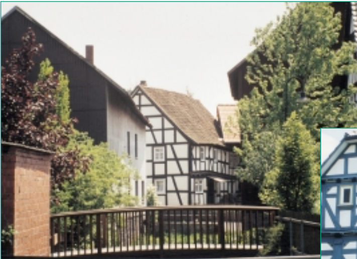
Brücke über die Solz
