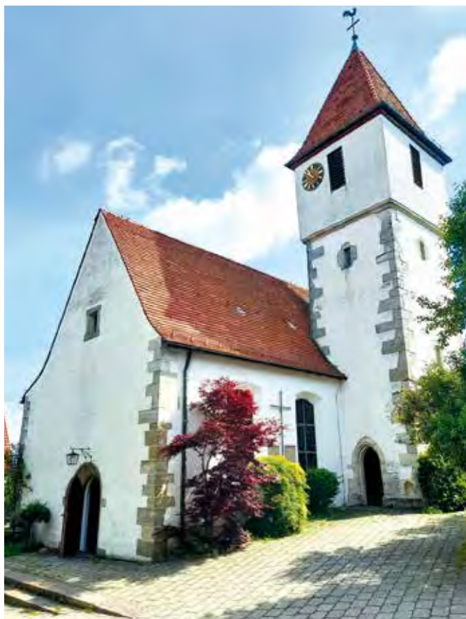
Ev. Pfarrkirche „St. Gereon und Margaretha“ Aichschieß
