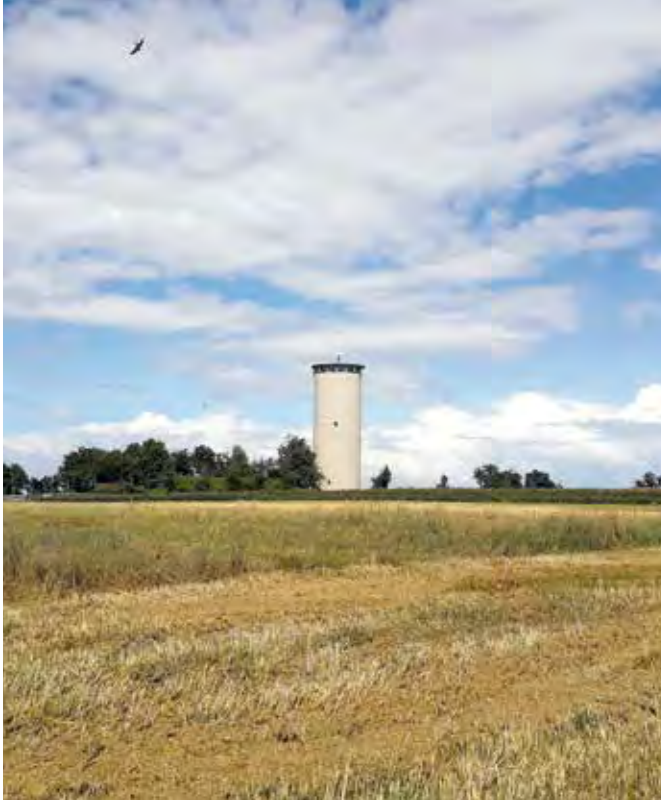
Der Recyclinghof befindet sich beim Wasserturm Krummhardt.
