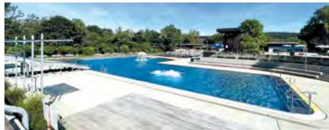
Freibad Reichenbach, Foto: Firma Bäderlife GmbH
