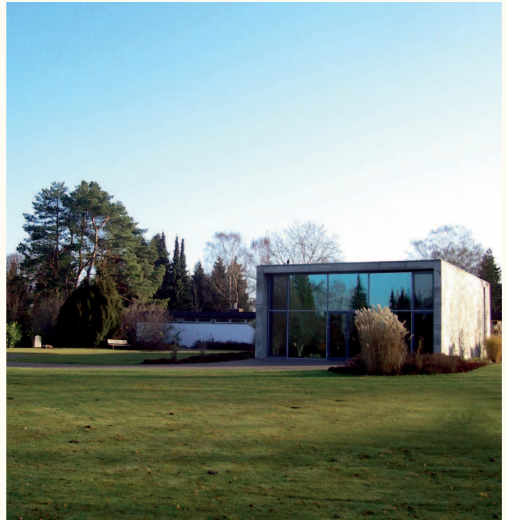
Feierhalle III auf dem Stadtfriedhof (neuer Teil)
