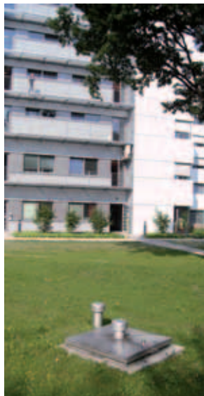
Das Krankenhausgebäude wird mittels Brunnen mit Grundwasser gekühlt
