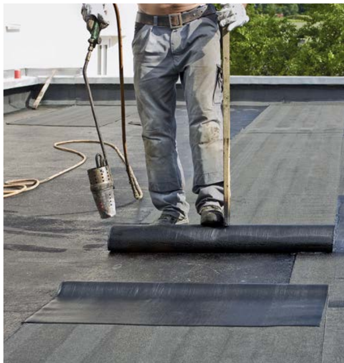
Abdichtungsarbeiten auf einem Flachdach
