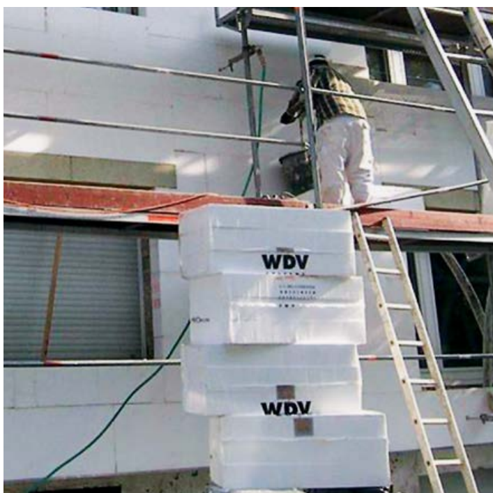
Anbringen eines Wärmedämmverbundsystems
