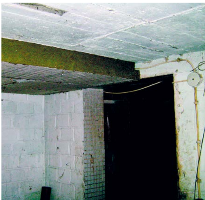
Dämmung der Kellerdecke von unten
