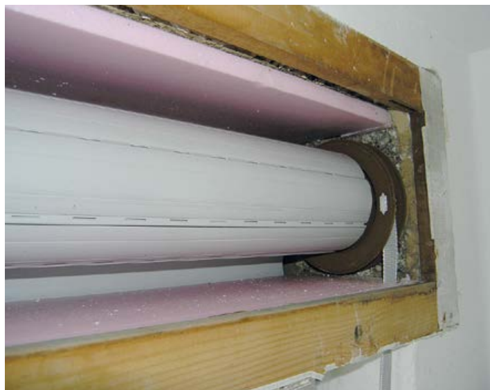
Nachträgliche Dämmung eines Rollokastens
