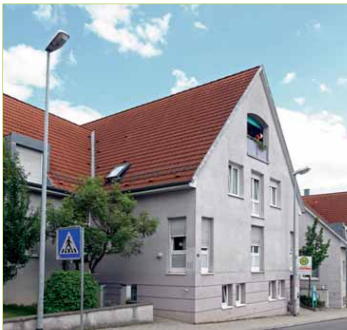
Altenwohnanlage „Am Lindle“ – Bonlanden
