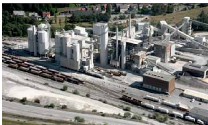
Kalkwerk der Felswerke in Rübeland
