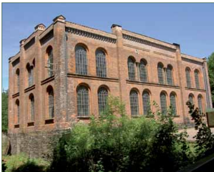
Industriedenkmal Carlswerk in Mägdesprung
