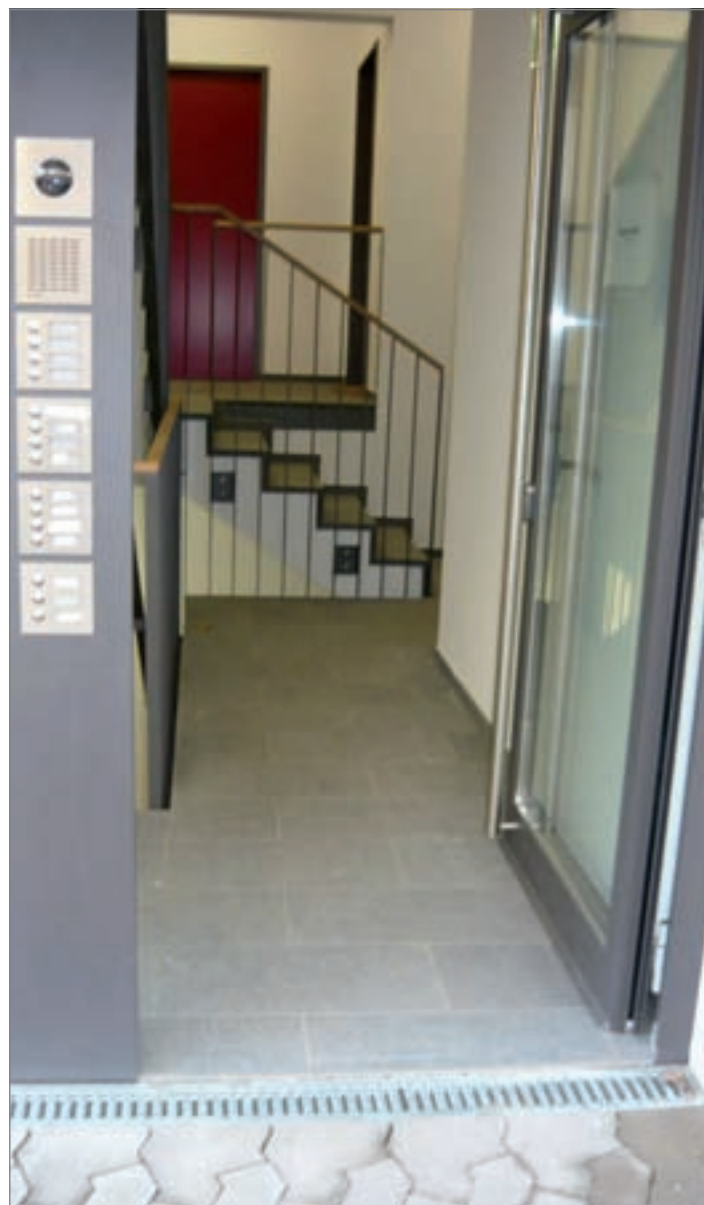
Barrierefreier Eingang – Umbau gefördert von der Stadt Heidelberg aus Mitteln des Programms zur Schaffung barrierefreier Miet- und Eigentumswohnungen Foto: Stadt Heidelberg
