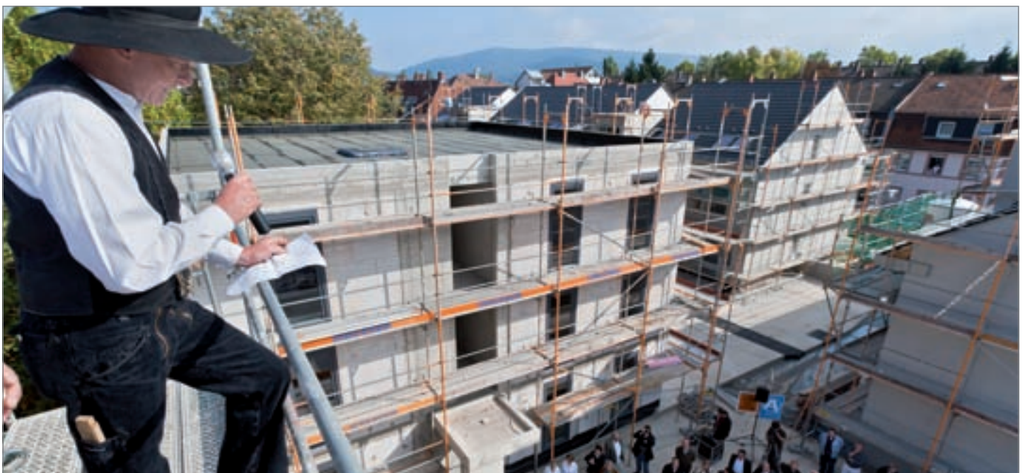
Neubau und Sanierung: Die Gesellschaft für Grund- und Hausbesitz feiert Richtfest im Wohngebiet Wieblingen-Ost
