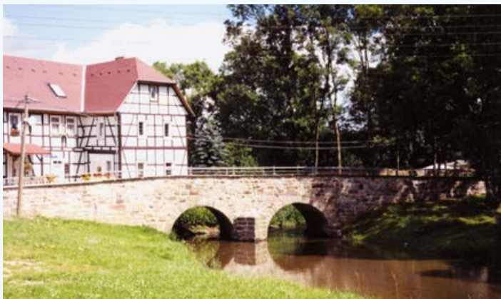
Stadtteil Häselrieth / Doppelbogen-Werrabrücke
