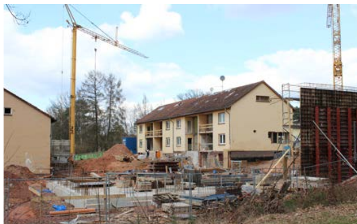
Baustelle der neuen Musikschule
