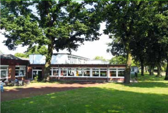
Energetische Sanierung der St.-Georg-Grundschule
