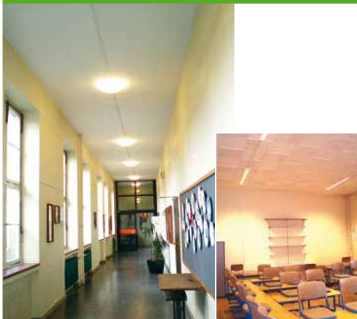
LED – Innenbeleuchtung im Freiherr-vom-Stein-Gymnasium
