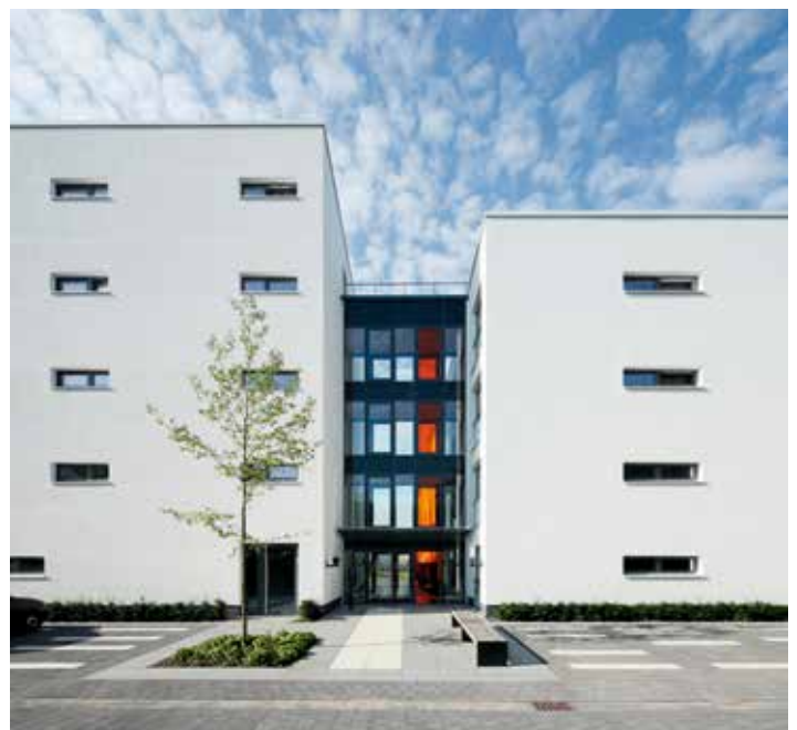
Studentenwohnanlage Briener Straße, Kleve Foto: © Hans Jürgen Landes – Ansicht von Südosten
