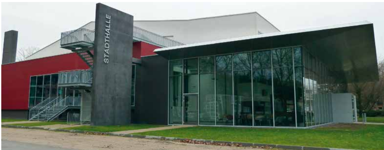
Energetische Sanierung Stadthalle in Kleve
