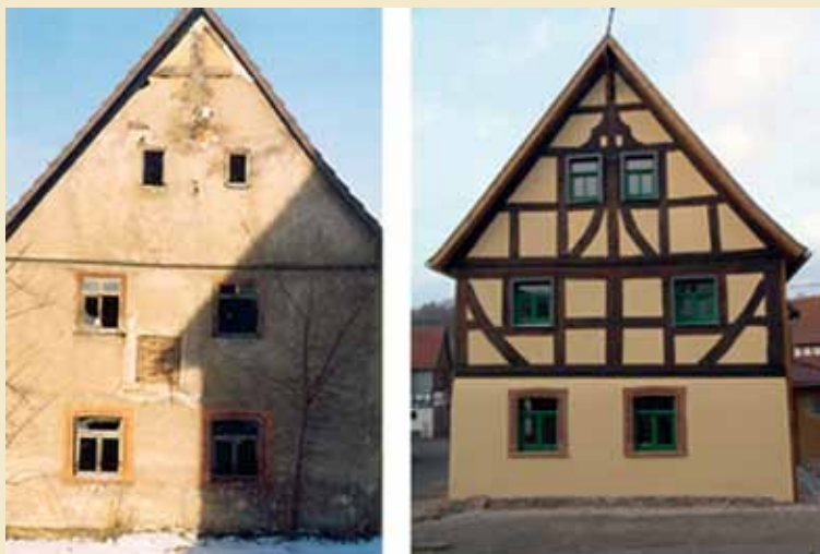
Vorher – nachher. Denkmalgerechte Sanierung in Ulrichstein-Wohnfeld.
