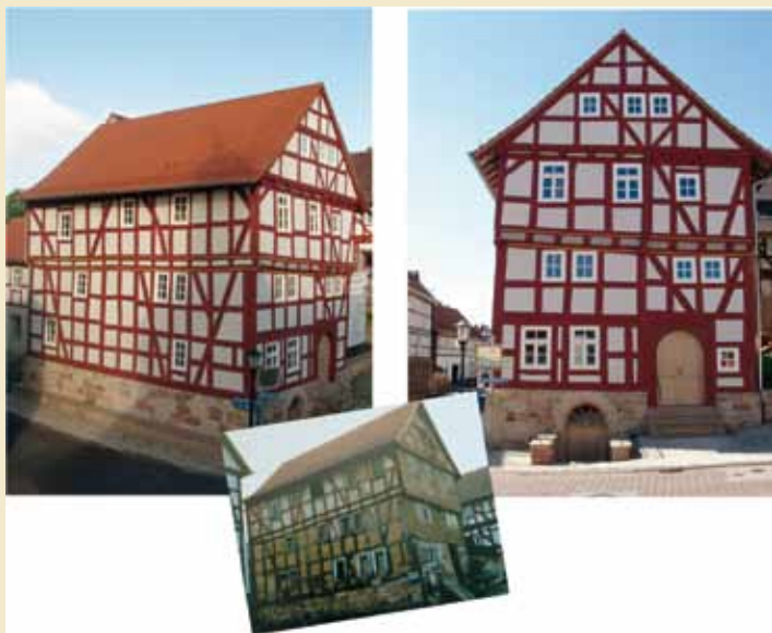
Museum Kirtorf – Umbau eines denkmalgeschützten Wohngebäudes zu einem Kulturzentrum.
