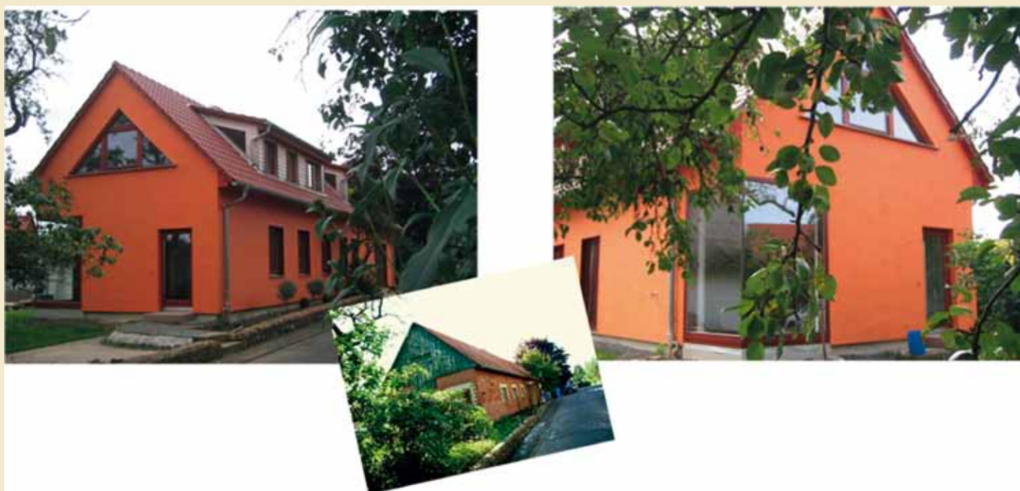
Umbau eines Schweinestalls zu einem Architekturbüro in Grebenhain-Bermuthshain.
