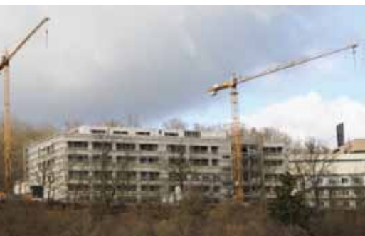
Neubau Eichhof Krankenhaus; Lauterbach
