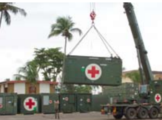
Kommandobereich Follow-on-Forces beim Containeraufbau
