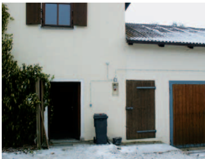
Bei diesem lieblosen und tristen Eingang fällt man auch noch fast in die Mülltonne. So wird bei jedem Betreten des Hauses auch noch die Müllenergie mit hinein getragen.
