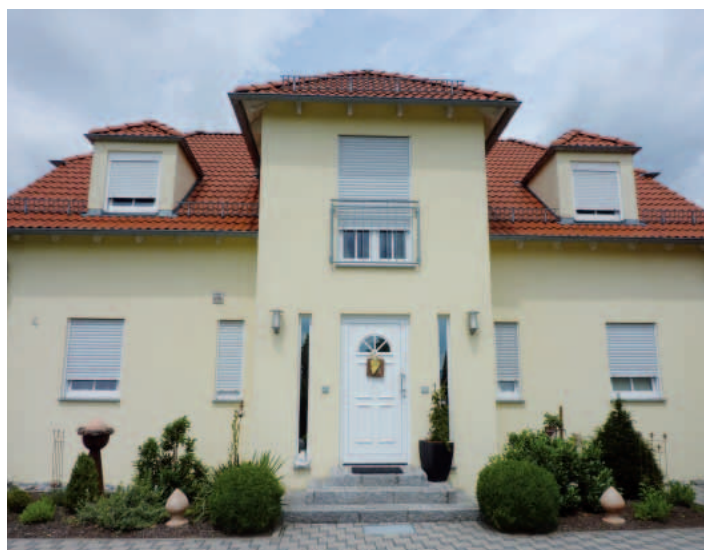
Dieser großzügig und freundlich gestaltete Eingang heißt Besucher wie Bewohner gleichermaßen willkommen. Hier kann sich die gute Energie voll entfalten.
