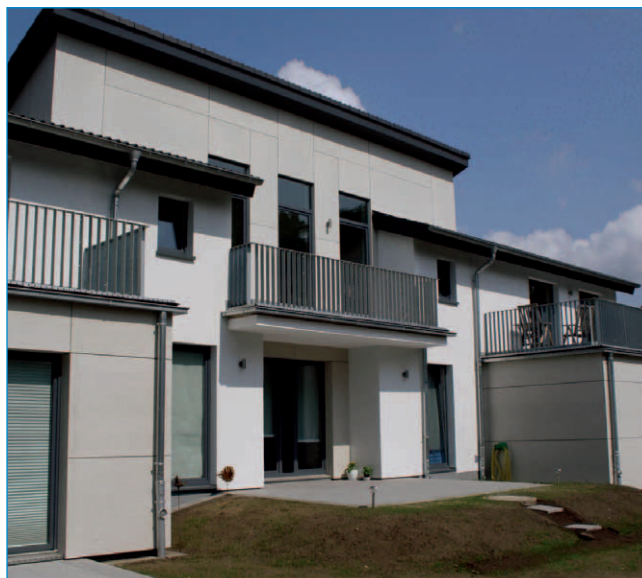
KfW 70 Wohnhaus mit Erdwärmepumpe
