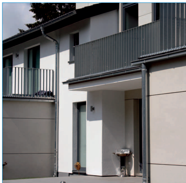
KfW 70 Wohnhaus mit Erdwärmepumpe
