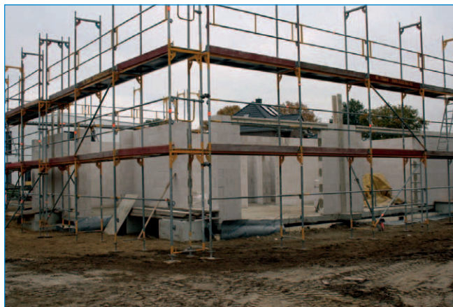
Neubau Einzelhaus in Norderstedt
