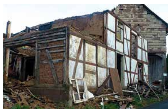
Foto: K. Kühne, Abriss eines baufälligen Wohngebäudes in Dassel
