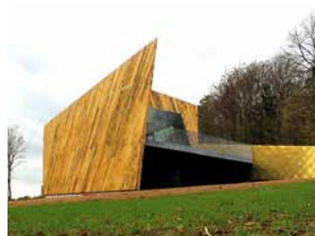
Foto: T. Grimme, Infogebäude am Harzhorn
