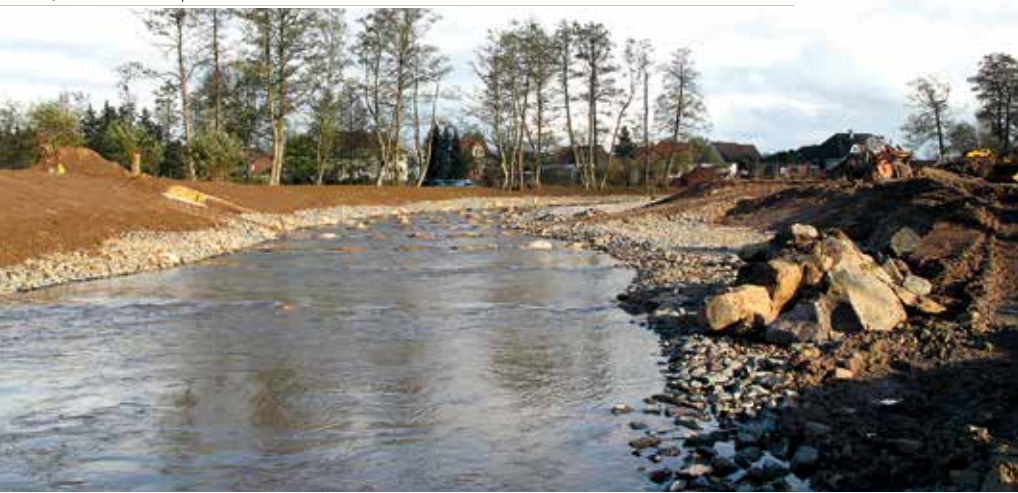
Foto: J. Heitkamp, Rhume bei Lindau nach Rückbau des Wehrs
