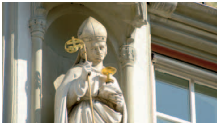
Detailaufnahme der Fassade des Amtshauses.
