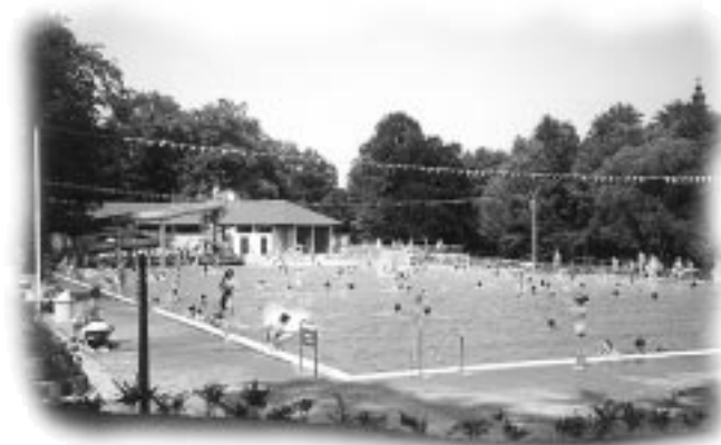
Ansicht des Kombinationsbeckens = 1250 m 2 Wasserfläche, davon 500 m 2 Schwimmer-, und 750 m 2 Nichtschwimmerbereich. Planschbecken = 63 m 2 Wasserfläche, modernes Funktionsgebäude, Filteranlage, gesamtes Stadtbad behindertengerecht, Kiosk mit Terrasse.
