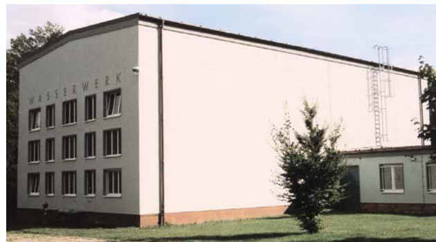
Wasserwerk Döbern Jerischker Weg nach der Rekonstruktion
