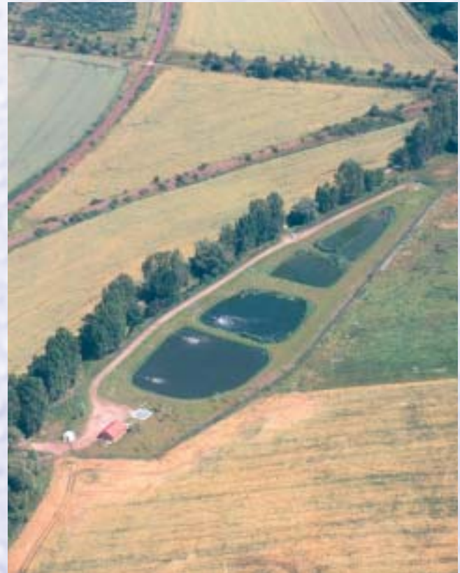
Teichkläranlage Bad Suderode
