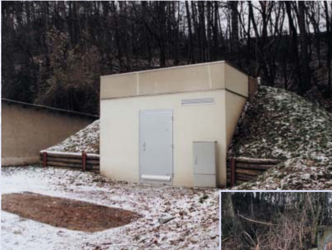
Pumpstation Gernrode / Haferfeld
