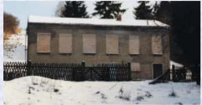
Altes Wasserwerk Straßberg nach der Stilllegung
