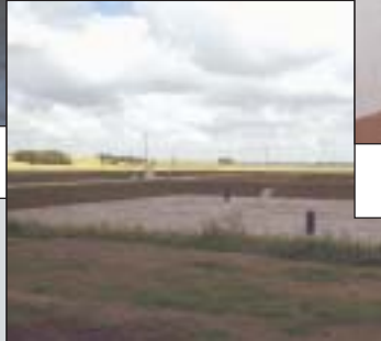
Klärschlammvererdung auf der Verbandskläranlage Hoym / Nachterstedt
