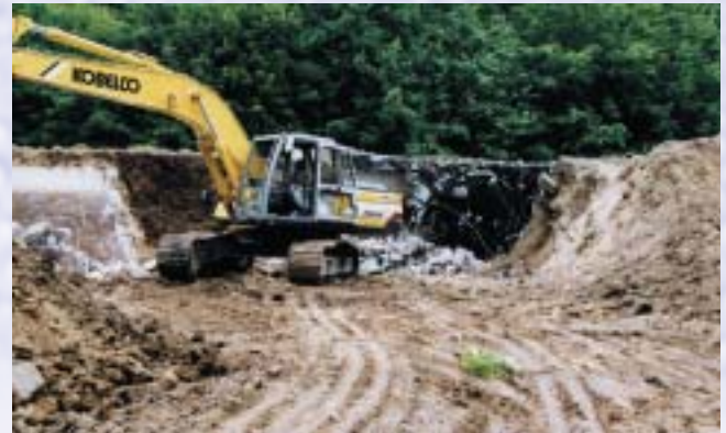
Abbrucharbeiten Erdtiefbehälter
