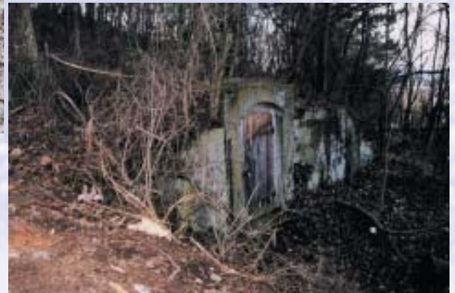
Historischer Trinkwasserspeicher Gernrode / Haferfeld
