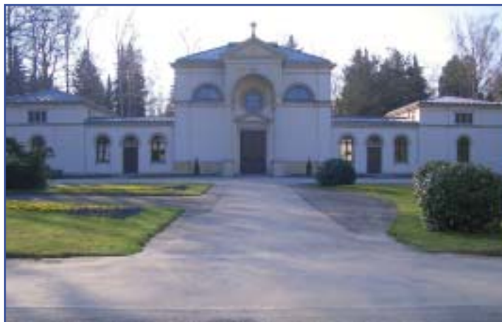
neu rekonstruierte Feierhalle
