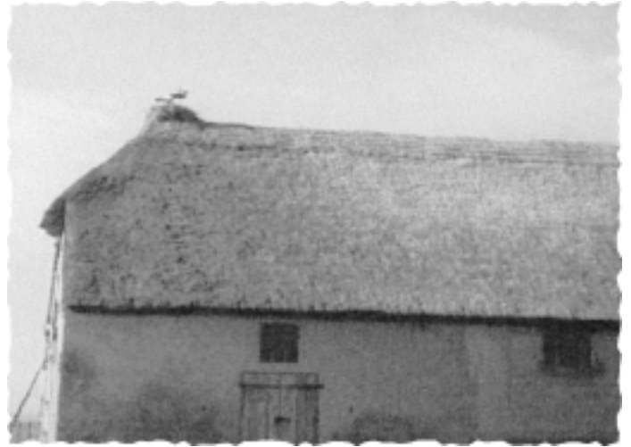
Reet-Dach des ehemaligen Gutpferdestalles
