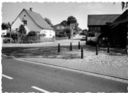
Sanierter Straßen- und Gehwegbereich
