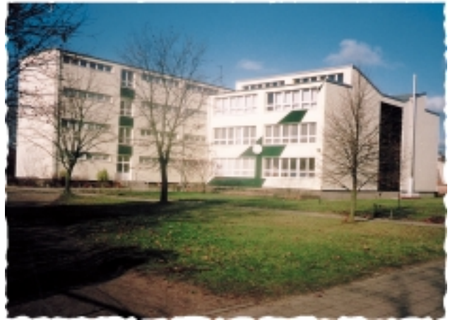
Sanierte Haupt- und Realschule Ferdinandshof
