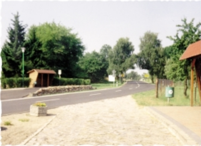
Sanierte Straße und Gehwege am Ortseingang
