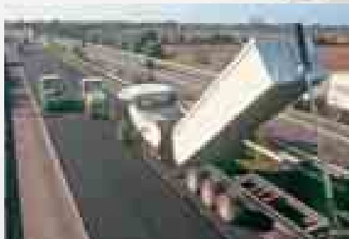
Herstellung einer Asphaltdecke
