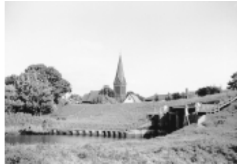
Verlatzschleuse mit Kirchturm in Borsfleth
