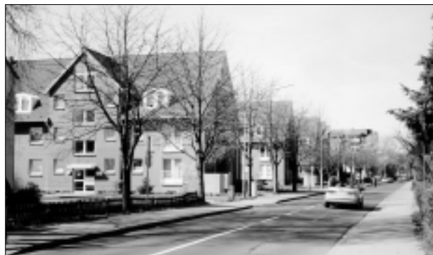
Feldbehnstraße – Wohnhäuser der WOBAU
