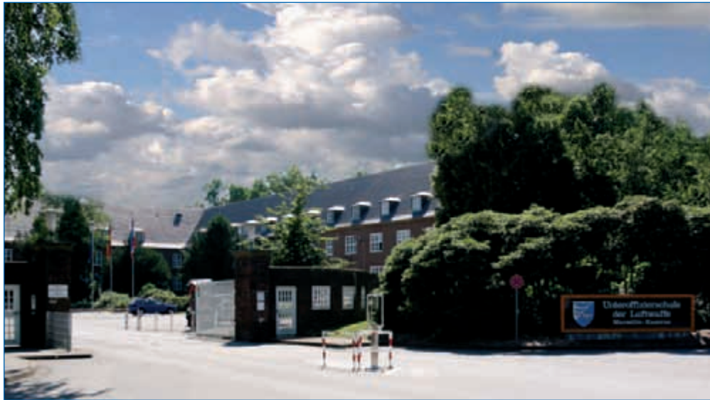
Kaserneneinfahrt der Marseille-Kaserne in Appen.
