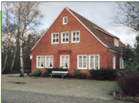
Heimathaus des Heimatvereins Moormerland an der Dr.-Warsing-Straße
