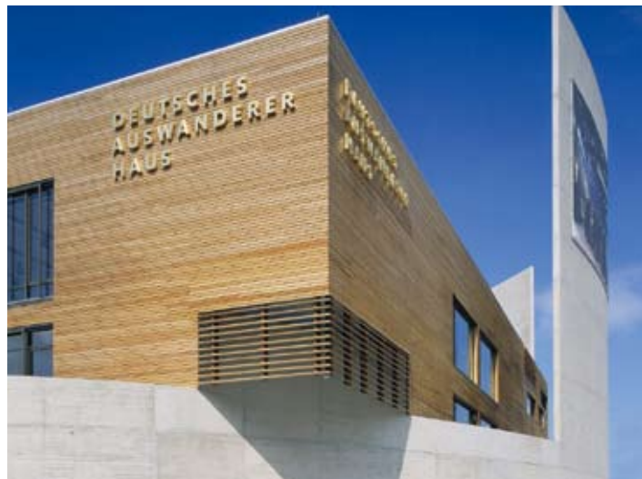
Außenansicht des Deutschen Auswandererhauses
