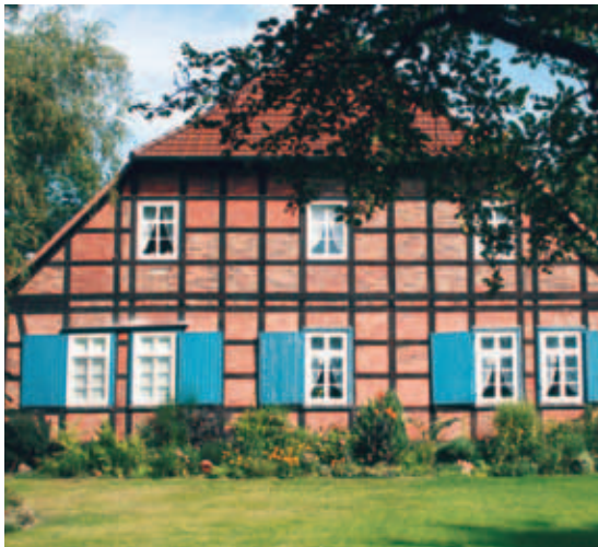
Typische Bauweise – das Fachwerk Foto: H. Neddermeyer
