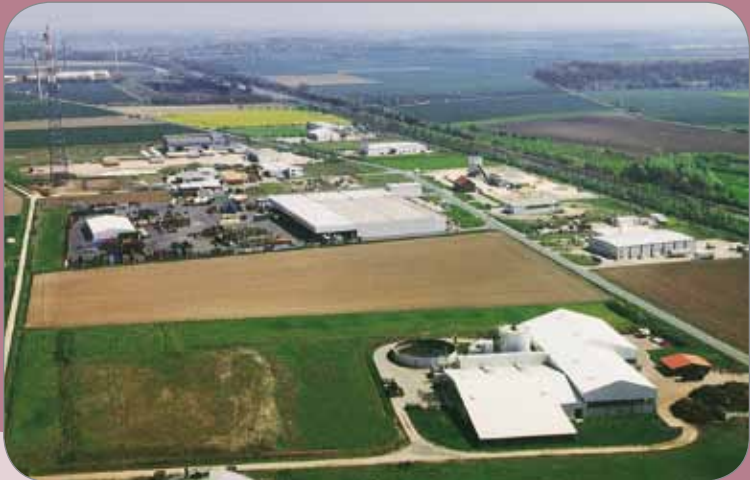
Blick vom Kraftwerk auf das Industriegebiet „Ackerköpfe“, Ortschaft Mehrum
