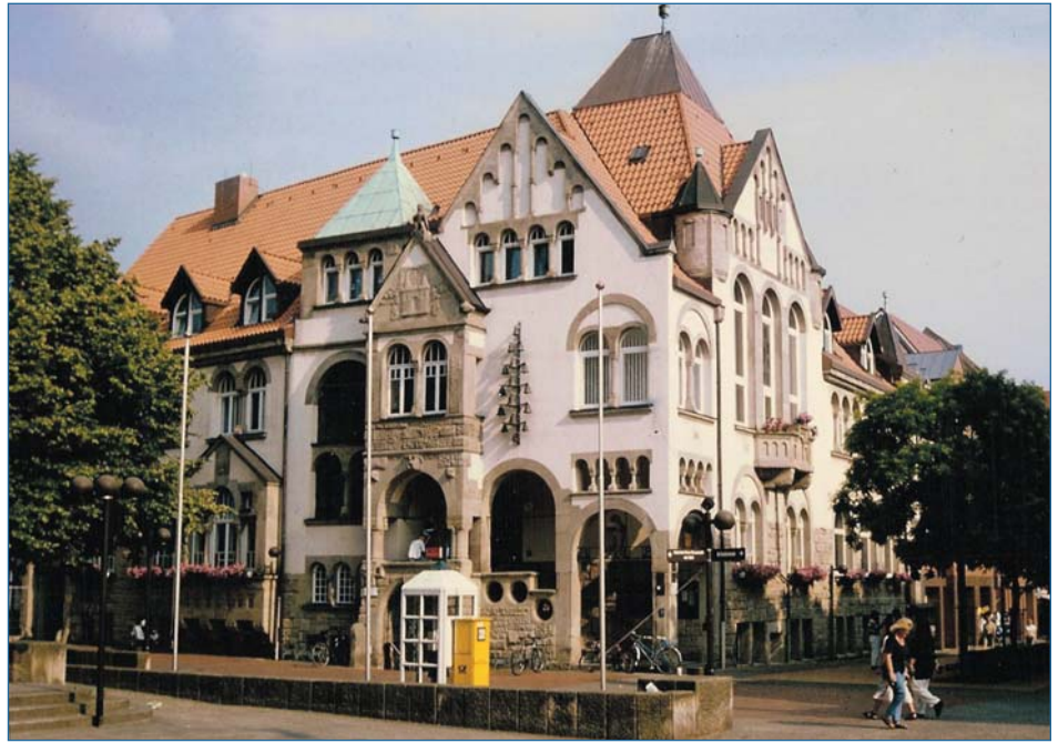
Wieder wie neu: Das Rathaus mit sanierter Fassade
