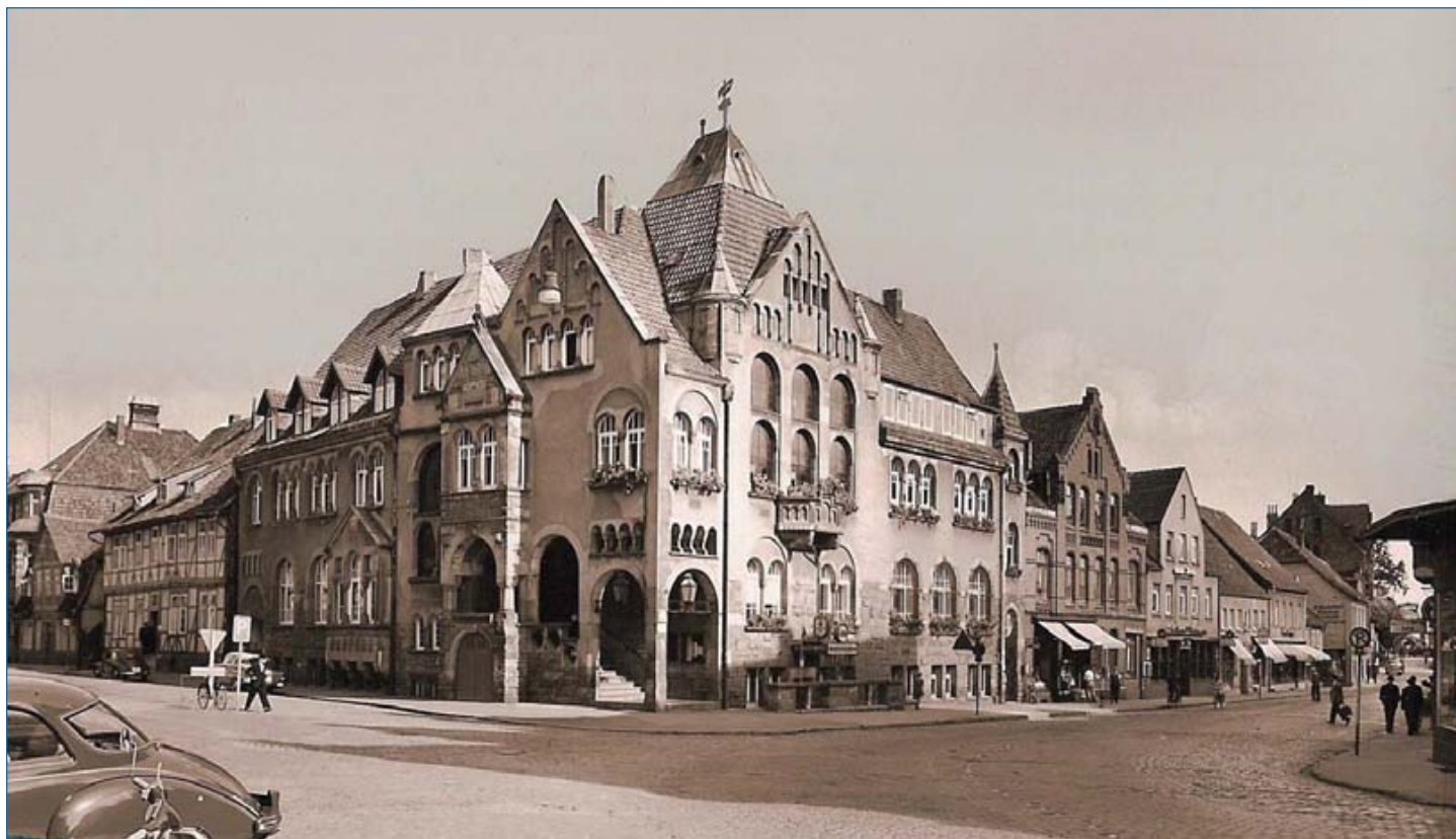
Rathaus in den 1950er/60er Jahren mit veränderter Dachgaube an der Südstraßenseite
