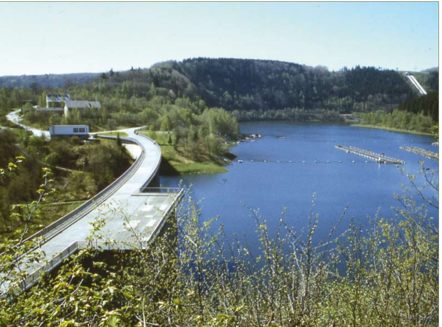
Die Rappbode-Talsperre gehört mit einem Stauraum von 110 Millionen Kubikmetern zu den größten deutschen Talsperren.
