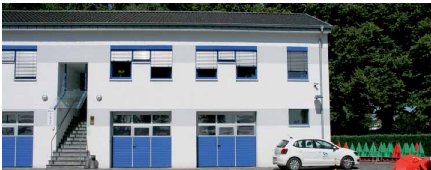
Wasser- und Schifffahrtsamt
