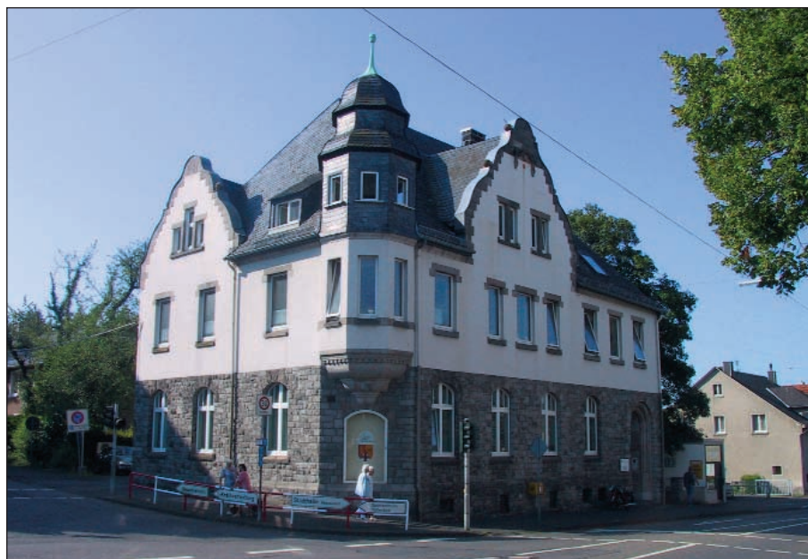
Zulassungsbehörde im Nebengebäude (Rathausstr. 12, Altenkirchen)
