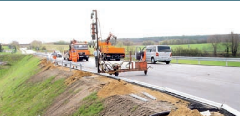
Montage Stahlschutzplanken
