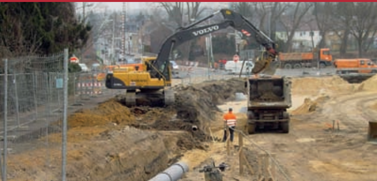
links unten: Herstellung Entwässerungsleitung im Bereich Lindenallee
